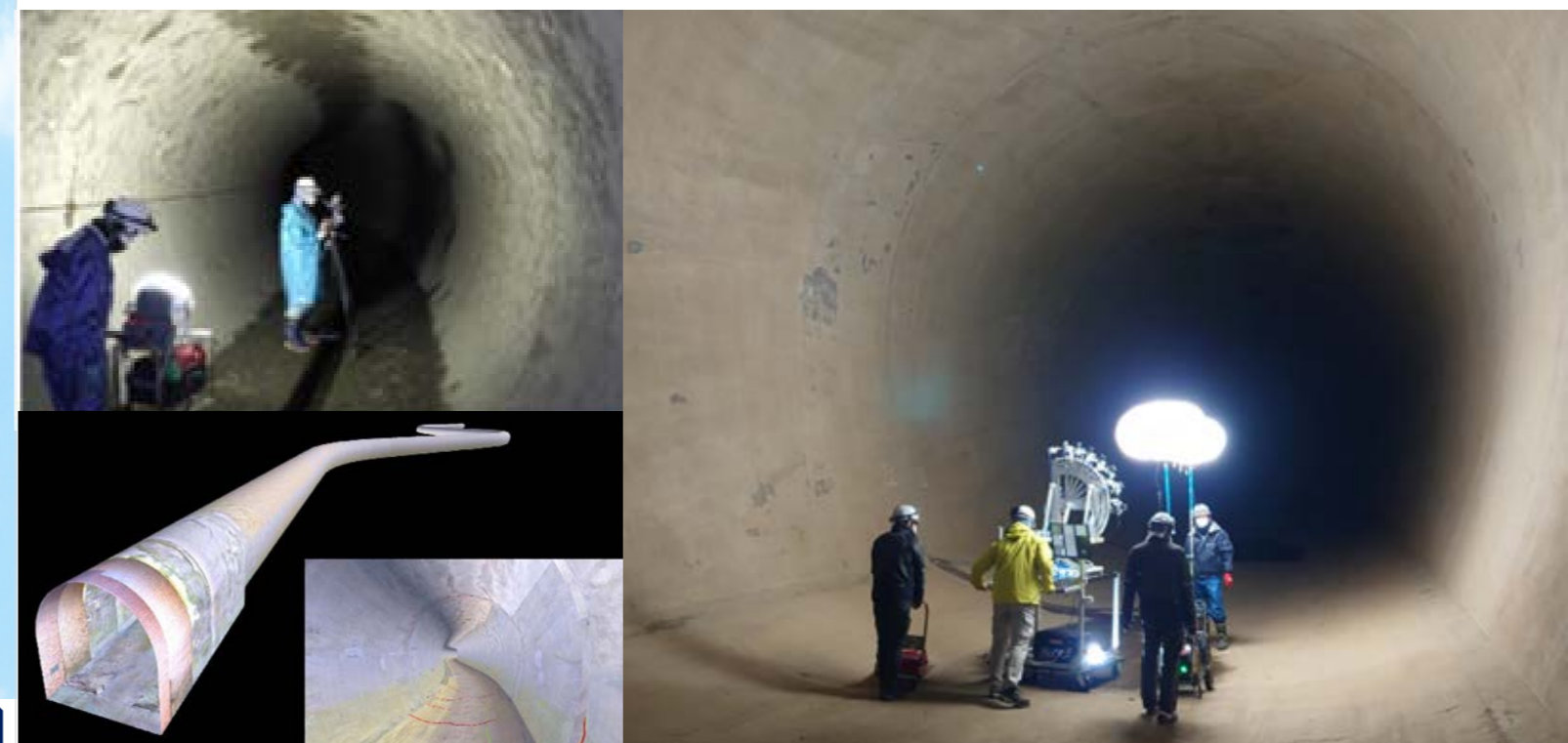
「点検風景・3Dモデル図/地下河川点検」
