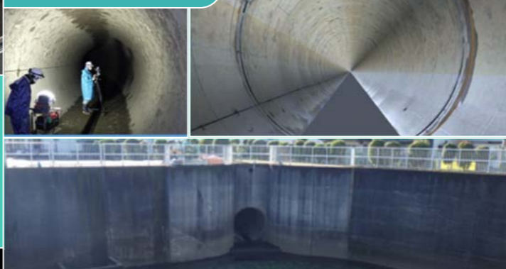
地下河川点検
