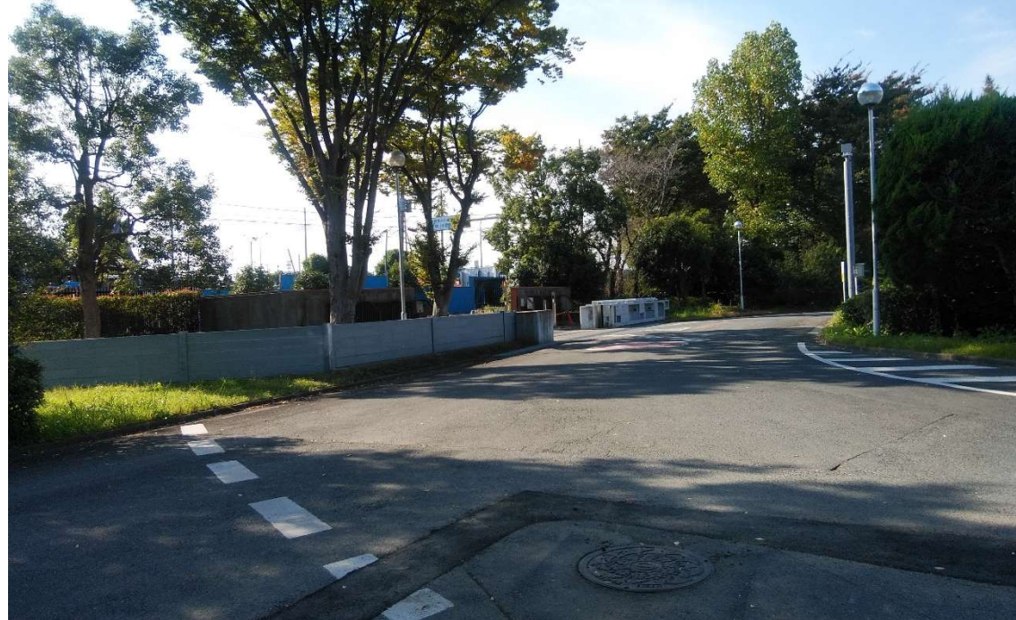
「(事例)耐水化防水壁 埼玉県荒川右岸流域下水道、新河岸川水循環センター」
