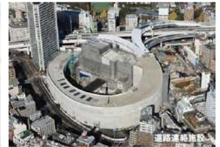
道路連絡施設
